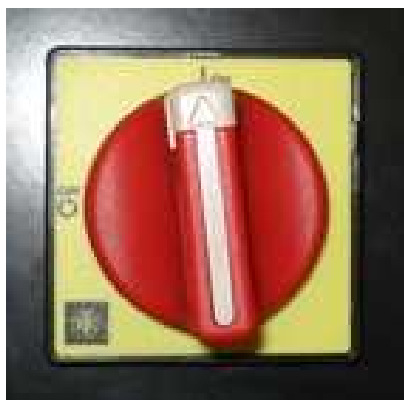
Sectionneur face avant en partie basse
