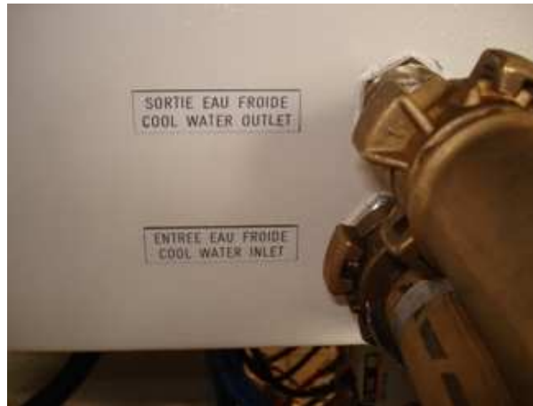
Entrée et sortie des servitudes d'eau
